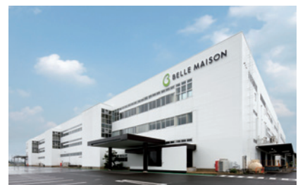
美濃加茂DC外観
